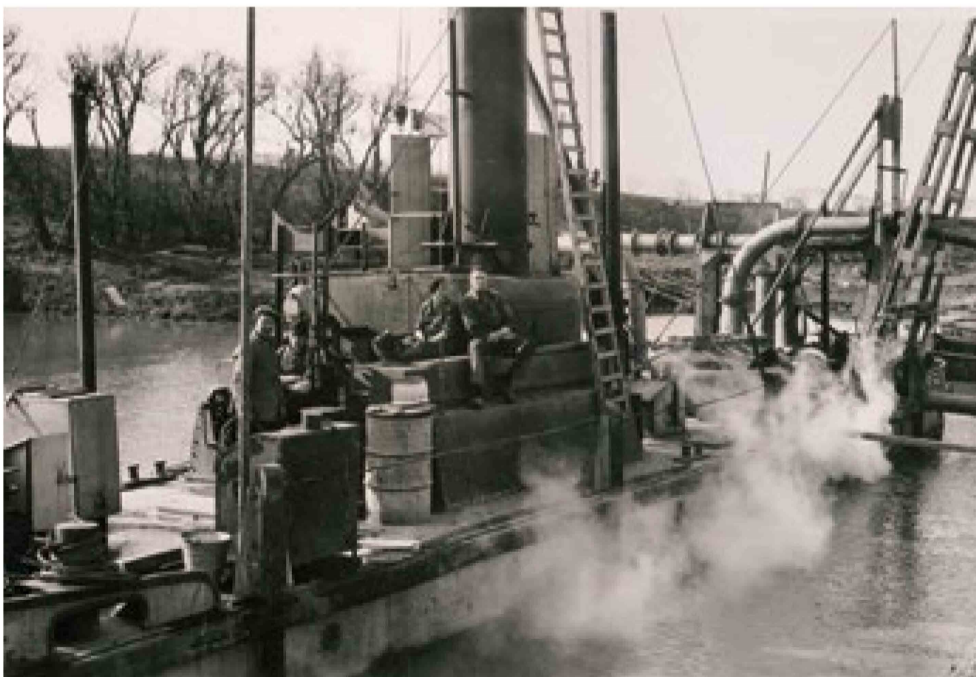
Een zandzuiger waarmee de buitenste tankgracht werd aangelegd. De foto is genomen ter hoogte van de Van Rijckevorselsluis. Foto fam. van den Ende
